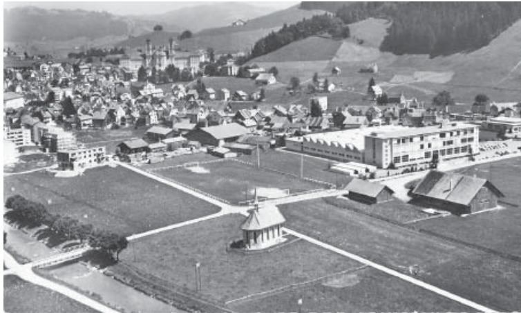
Flugaufnahme aus den frühen 1960er-Jahren. Der Langrütboden war grösstenteils noch unverbaut. Doch die grosse Fabrik der Landis & Gyr, Zug (rechts im Bild ist unübersehbar und hat damals der Region zu einer markanten Zunahme der Arbeitsplätze verholfen.
